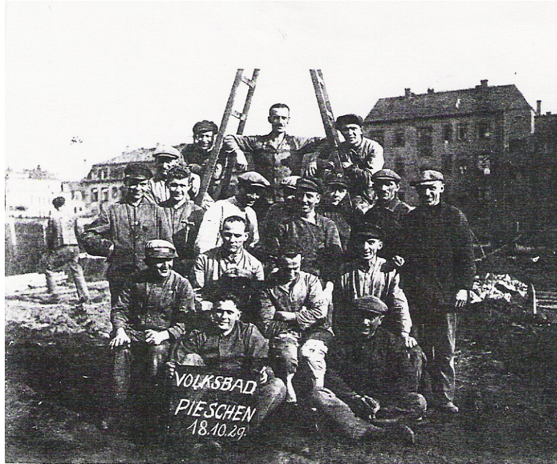
Abb. 1: Arbeiter bei der Fertigstellung des Sachsenbades im Oktober 1929 (Quelle: Herr Brendler, Geschichtswerkstatt Dresden-Nordwest)
